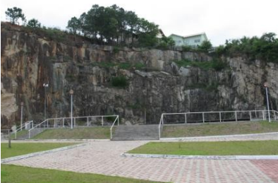
Vista Geral da Pedreira
