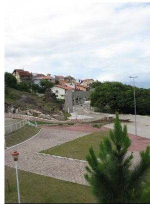
Vista do Acesso
