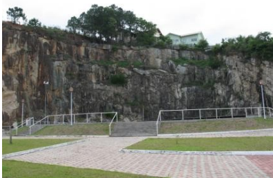
Vista Geral da Pedreira
